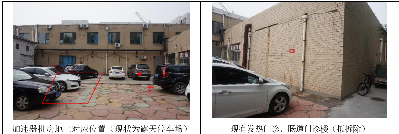
图 8-3 加速器机房拟建区域现场勘查时现状照片（拍摄于 2019 年 7 月）
