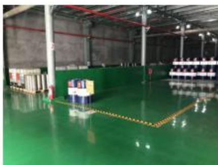
危险废物贮存间（库）
