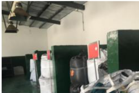
危险废物贮存间（库）
